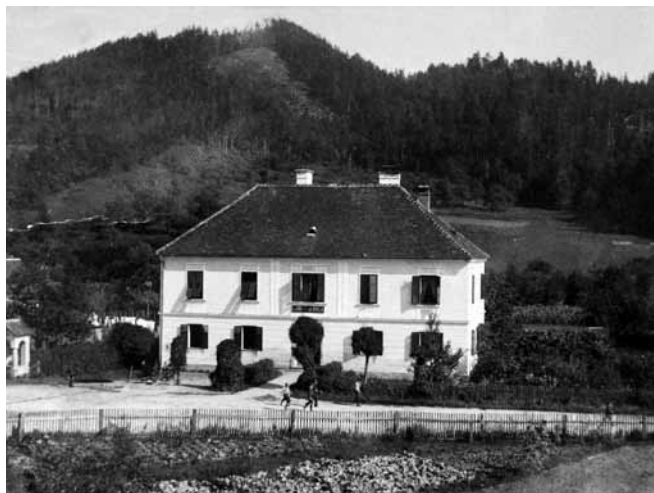
Krajevni šolski svet je leta 1907 sklenil, da bodo zunanost šolske stavbe polepšali, jo prepleskali, popravili streho in jo opremili z napisom »LJUDSKA ŠOLA«. (Vir: Peter Habe, Dobrna)
