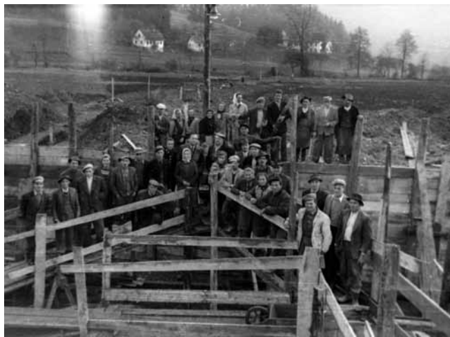
Gradbena dela, pri katerih so zavzeto sodelovali domačini, so se začela 26. 10. 1954. (Vir: družina Žužek, Klanc)
